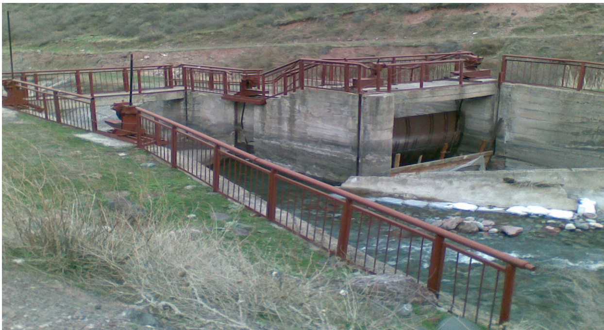
Рис. 2.5 Без плотинный водозабор.
