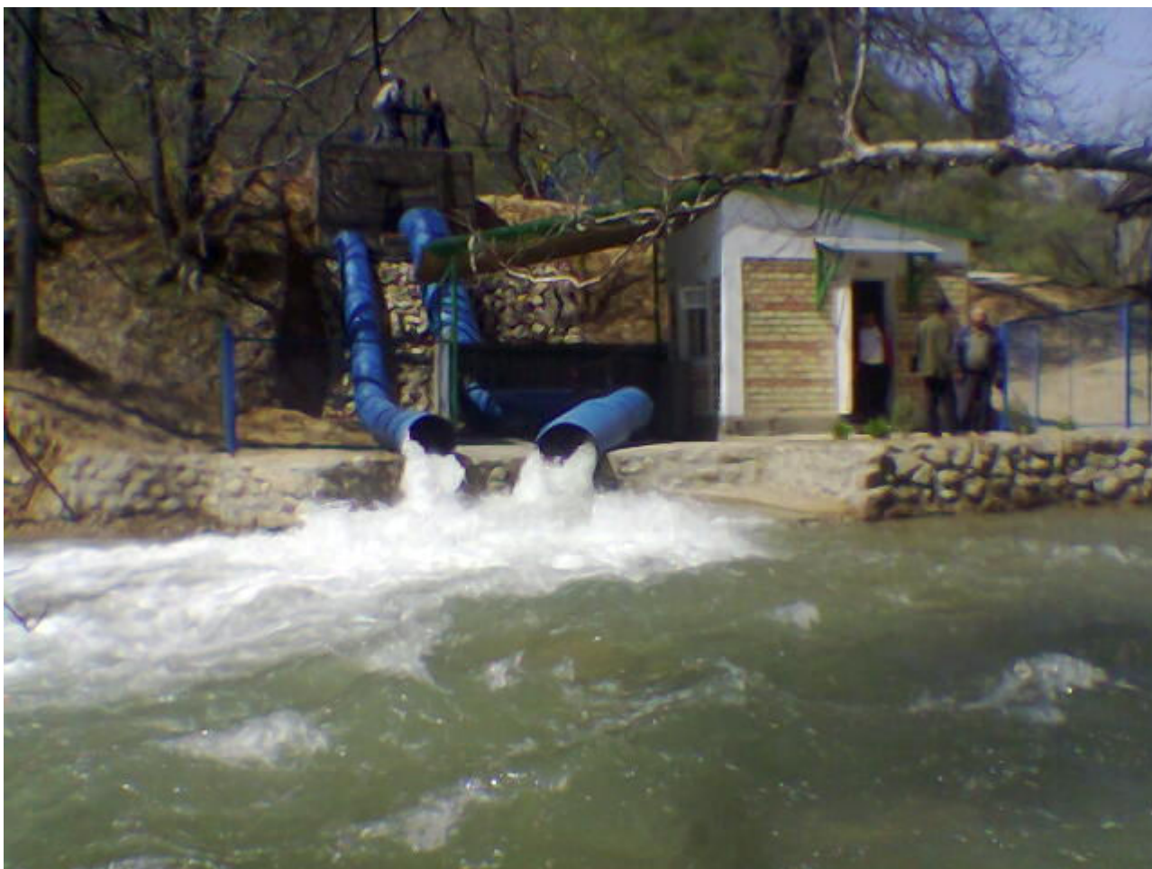
Рис. 6.10 Гидрогенератор мощностью 50 кВт с поворотнолопастной гидротурбиной в Сары Челекском заповеднике Жалал-Абадской области.
